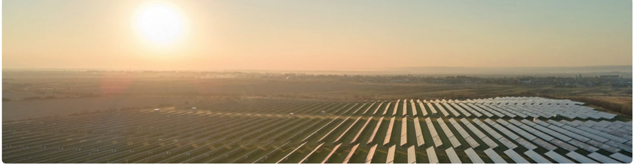
شكل 1.9: الطاقة الكهربائية النظيفة من الألواح الكهروضوئية الشمسية
